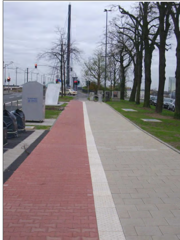
Bild 8-7: Getrennter Fuß- und Radweg
